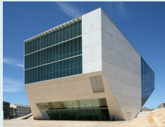
Fig. 8 – Bâtiment de la Casa da Música, à Porto (Source: https://commons.wikimedia.org/wiki/File:Casa-da-musica(exterior).1000.jpg#filelinks )
